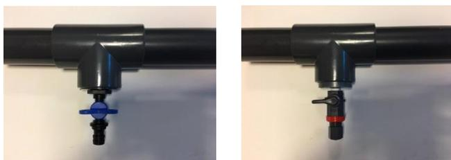
Prüfen Sie auch, ob sich in Ihrer Rückspüleleitung (das ist jene Leitung aus dem 6-Wege-Ventil welche zum Kanal führt und mit dem kleinen Schauglas am 6-Wege-Ventil –Körper ausgestattet ist) ein Absperrschieber befindet und öffnen Sie diesen eventuell vorhandenen Schieber. (Bild 7)
