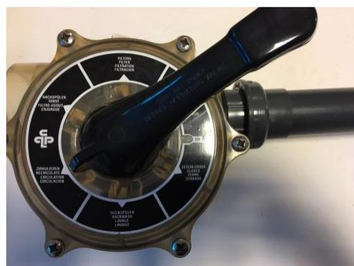
Nach dem Absenken die Filterpumpe ausschalten und vor dem Befüllen den **BAL-Schieber schließen**, den Hebel des 6-Wege-Ventiles auf „ZIRKULIEREN“ stellen. Bitte kontrollieren Sie das System auf seine Dichtheit, sichten Sie zur weiteren Vorgangsweise die Bedienungsanleitung Ihres Schwimmbades.
