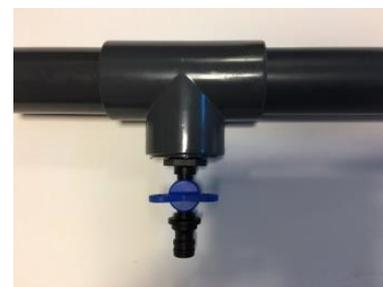
INFO: Die Schieber der Skimmer „SKI“ bleiben geschlossen (Griff steht „QUER“ zur Rohrleitung) zumal sonst die Filterpumpe beim Absenkprozess falsche Luft saugen würde und mit verminderter Leistung oder NICHT arbeiten würde. Das gilt auch für den eventuell vorhandenen „SAB“-und „ADR“-Schieber (Griff quer zur Rohrleitung); beide, SAB und ADR sind bitte geschlossen!
